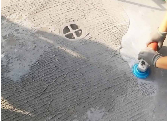
Werkzeug im Einsatz an einer Betonfläche
